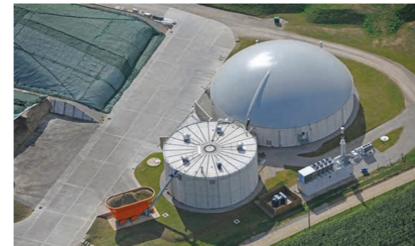
Biogasanlage Taverham (Großbritannien)
