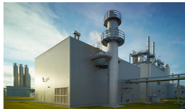
Dampfkesselanlage Zeitz der enviaTherm
